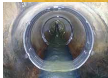
管きょ継手部連続施工
