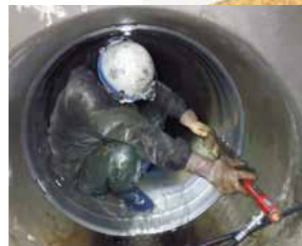
円形管ステンレススリーブ拡張状況
