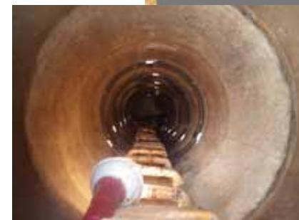
マンホール目地部連続施工
