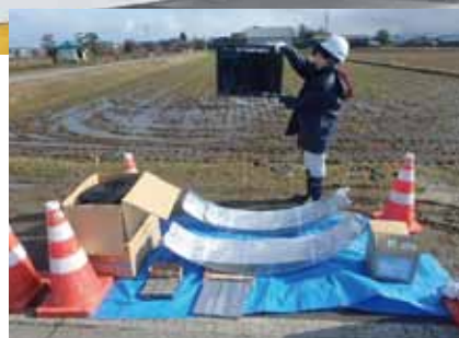
施工前材料確認状況
