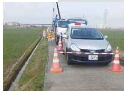
農水用水地域での施工状況
