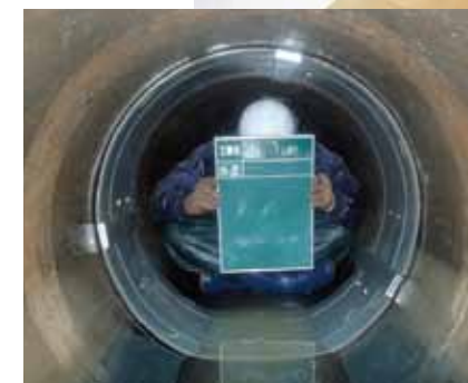
スナップロック工法ML 施工後
