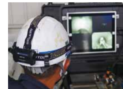
遠隔施工装置の作業状況 (テレビモニター)
