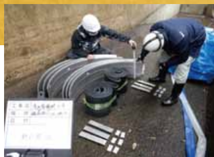
施工前材料確認状況
