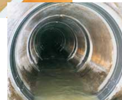
スナップロック工法ML 施工後
