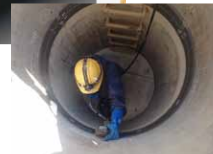
ステンレススリーブ固定金具挿入状況
