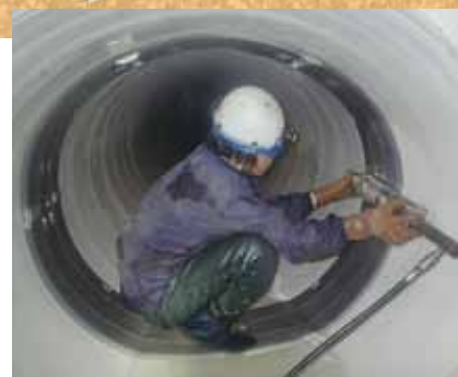
楕円管ステンレススリーブ拡張状況
