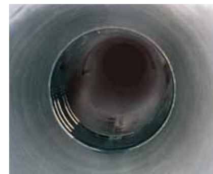
スナップロック工法S 施工後
