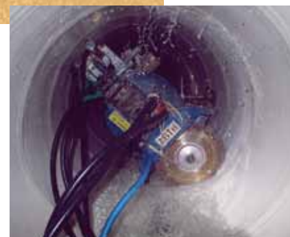
誘導目地切削状況
