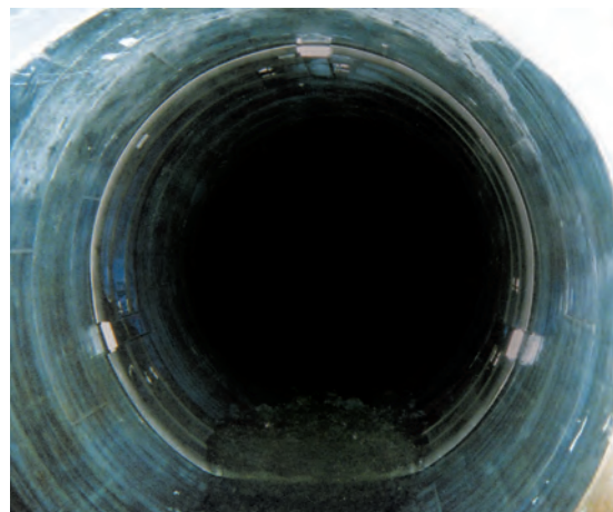
更生管の管口に設置
