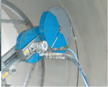
▲誘導目地の切り込みカッター
