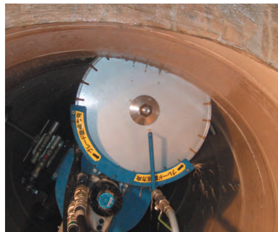
専用機による誘導目地切削状況
