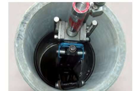
固定金具を圧入してミニマグマを設置
