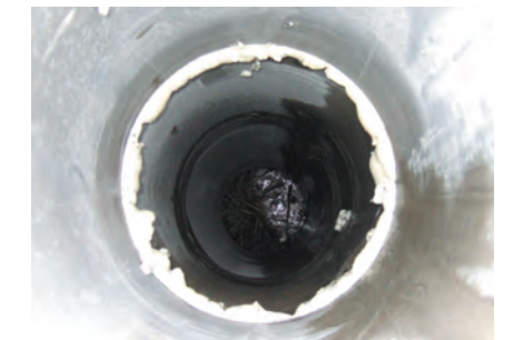
シール材充填後の状況
