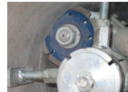
誘導目地切削状況
