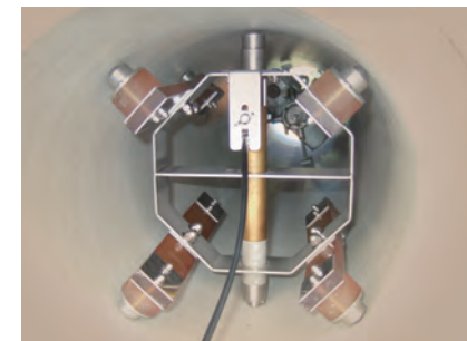
管内径測定状況
