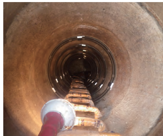
大深度マンホール目地への連続施工例
