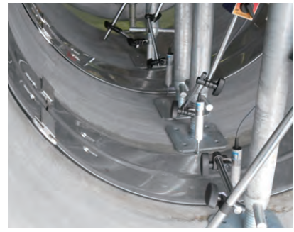
変位計設置状況
