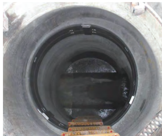
地震によるズレ発生箇所への施工例
