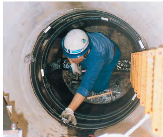
固定金具設置作業状況
