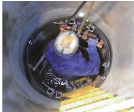
ステンレススリーブ拡径作業状況
