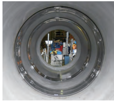
マグマロック設置状況
